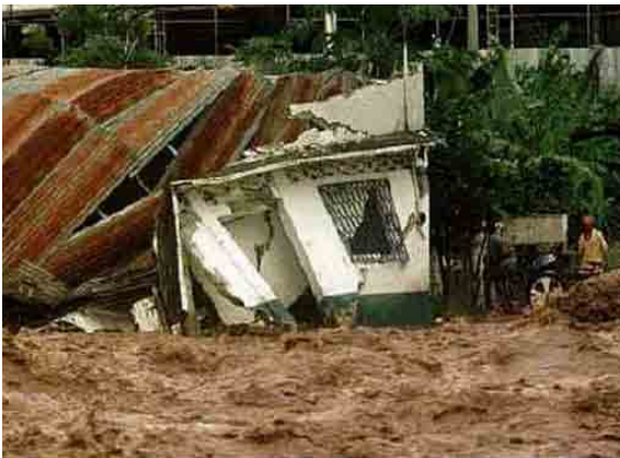
Figura 1.9 Daños ocasionados por Paulina.
